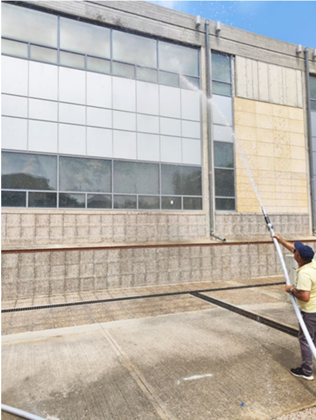
(ΝΕΟ ΚΤΗΡΙΟ ΒΙΒΛΙΟΘΗΚΗΣ ΜΕ ΔΟΚΙΜΗ ΜΕΣΩΝ ΕΝΕΡΓΗΤΙΚΗΣ ΠΥΡΟΠΡΟΣΤΑΣΙΑΣ)
