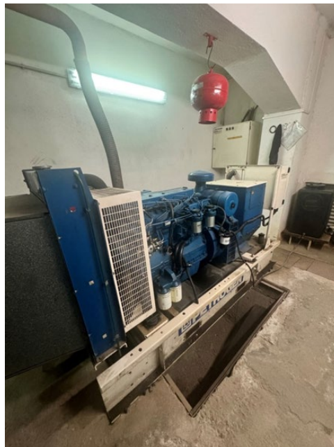
ΗΛΕΚΤΡΟΠΑΡΑΓΩΓΟ ΖΕΥΓΟ (ΓΕΝΝΗΤΡΙΑ ΑΠΡΟΣΚΟΠΤΗΣ ΠΑΡΟΧΗΣ ΗΛΕΚΤΡΙΚΗΣ ΕΝΕΡΓΕΙΑΣ ΣΕ ΠΕΡΙΠΤΩΣΗ ΔΙΑΚΟΠΗΣ ΡΕΥΜΑΤΟΣ)
