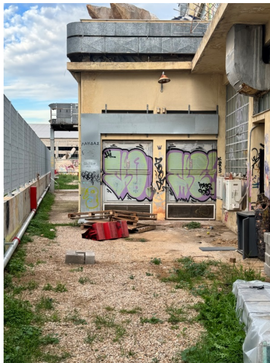
ΘΕΣΗ ΥΠΟΣΤΑΘΜΟΥ 2 (ΙΣΟΓΕΙΟ ΚΤΗΡΙΟΥ 3Α )
