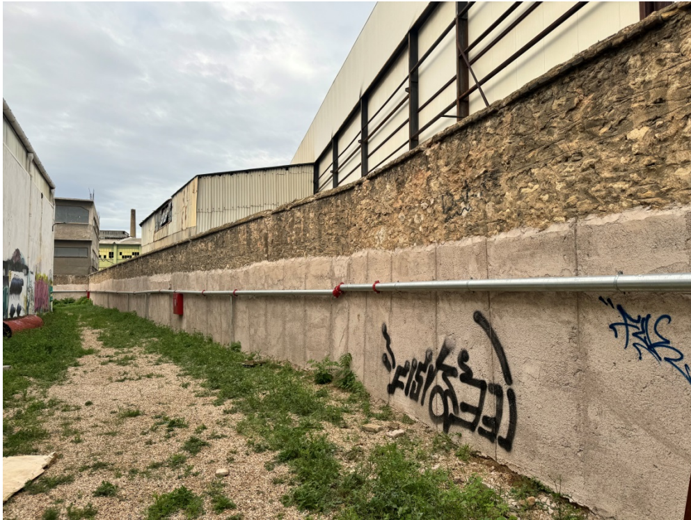
ΕΝΙΣΧΥΣΕΙΣ ΠΕΡΙΜΕΤΡΙΚΗΣ ΛΙΘΟΔΟΜΗΣ ΣΤΗΝ ΠΛΕΥΡΑ ΤΟΥ ΦΕΣΤΙΒΑΛ ΑΘΗΝΩΝ
